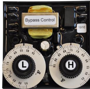
FIGURE 1.1.0 DRY BULB CONTROLLER
